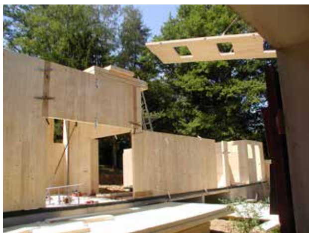
Woning, Frankrijk - voorzien van houten vloeren
