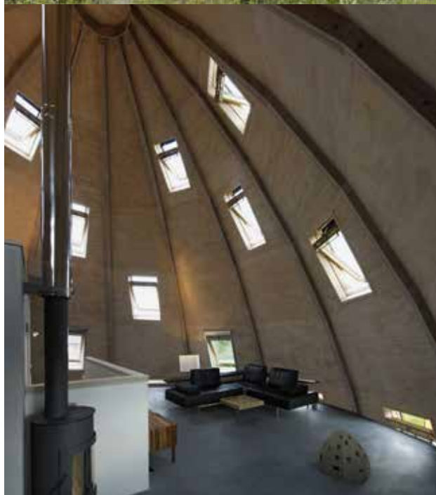
Woning 'De Korf', Almere - bijzondere vorm met lichte staalconstructie en houten binnenspouwblad
