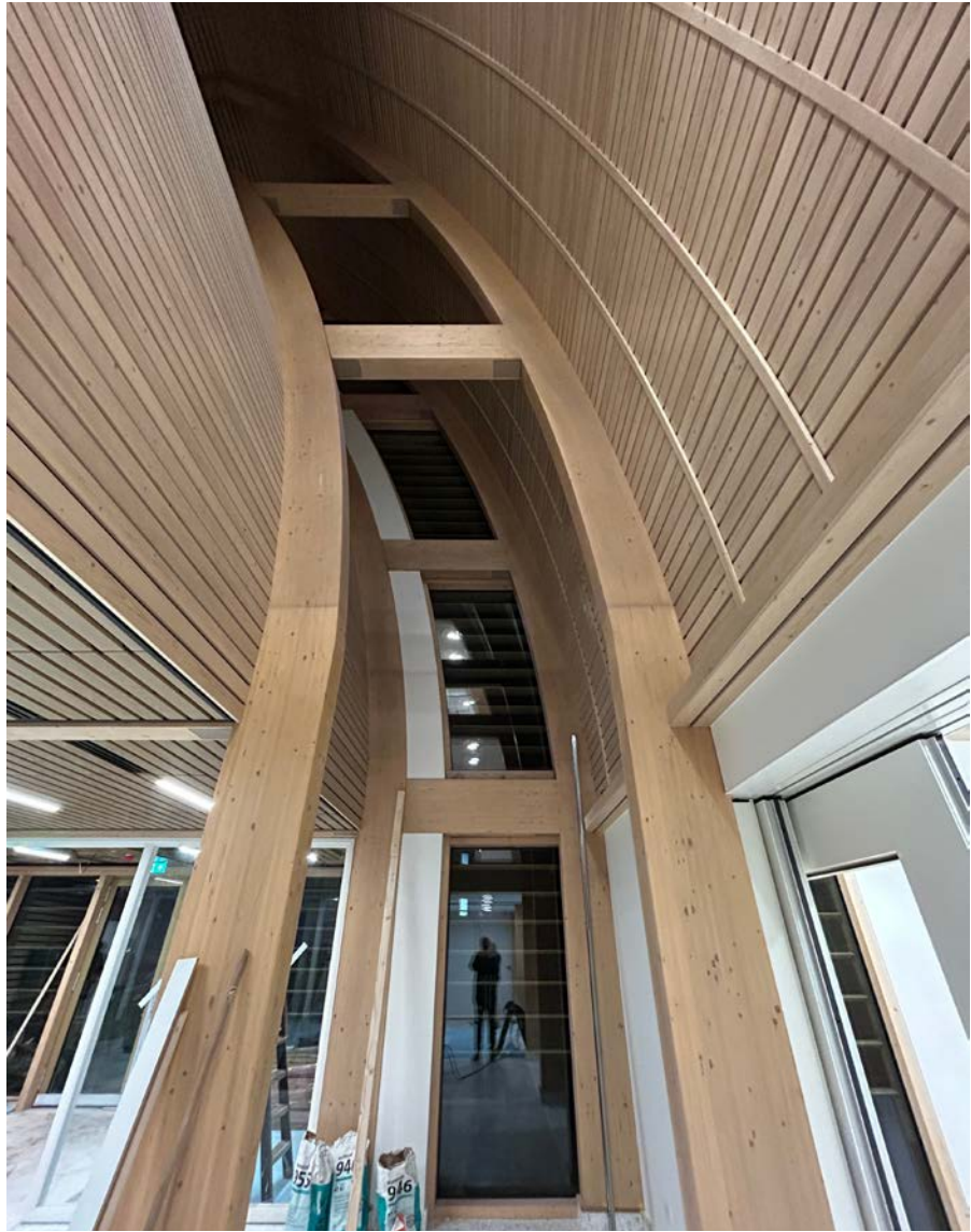
Constructie en architectuur gaan hand in hand in de Hoofddorpse kerk. De houten spanten van het interieur worden doorgetrokken naar buiten.
